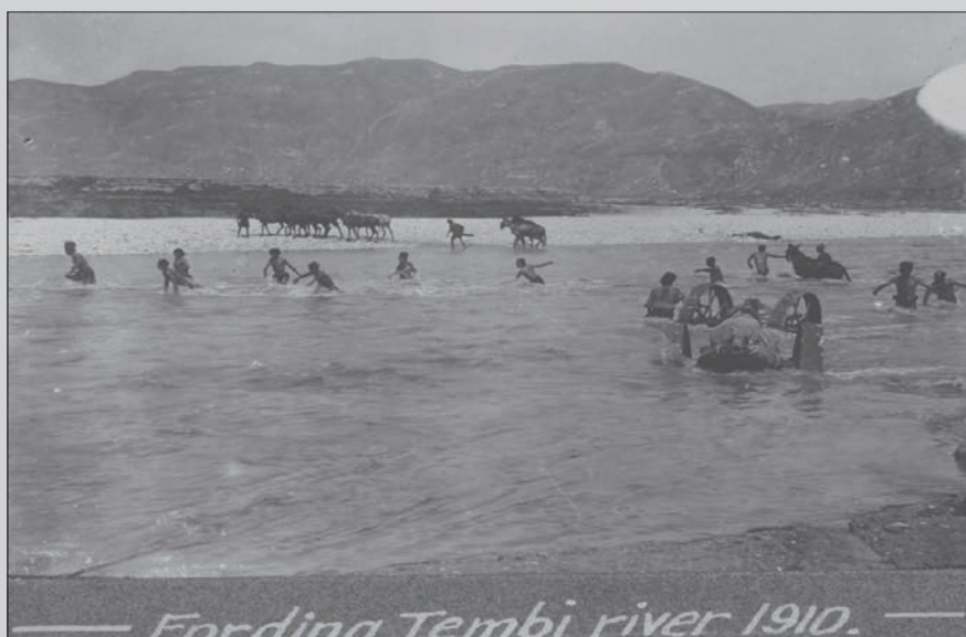
انتقال لوله های نفت با تلاش بختیاری ها از رودخانه تمبی - ۱۲۸۹
